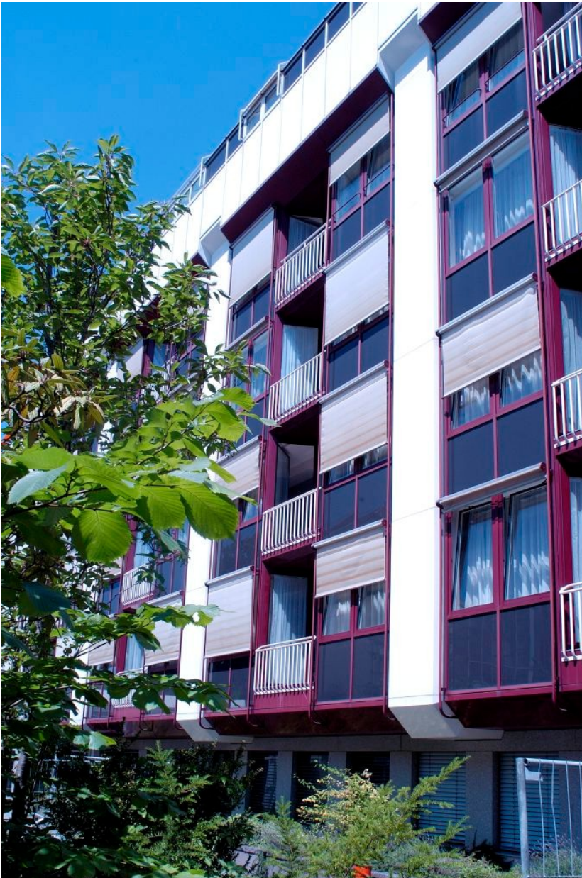
Blick auf die Südseite der Klinik
